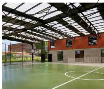
Battelsesteenweg 50A - overdekt voetbalveld ontwerp S3A architecten
